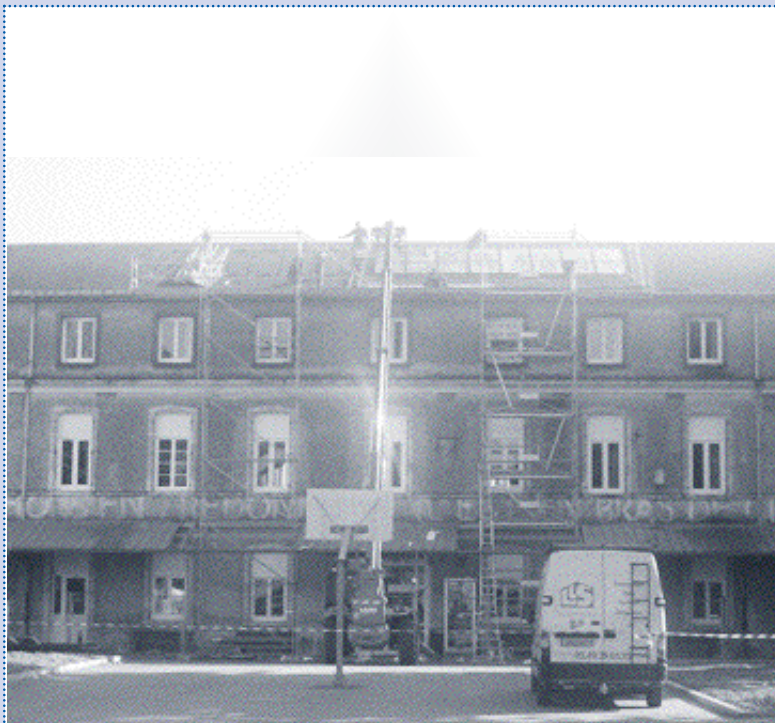
Fig. 3 : Depuis octobre 2008, la région a installé des panneaux solaires pour l'eau chaude sanitaire de l'internat. Les 32 m 2 de capteurs devraient couvrir 53 % des besoins et permettre d'économiser plus de 21 MWh de gaz par an.
