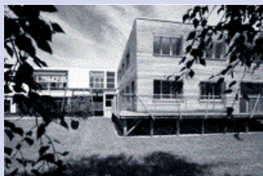
Le lycée CARNOT-SAMPAIX à Roanne, premier lycée en Rhône-Alpes à obtenir la certification HQE®.
